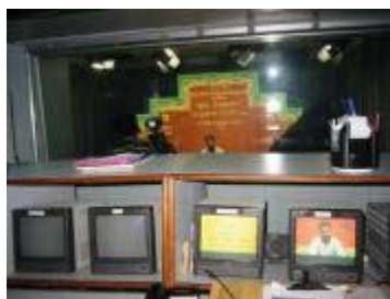
スタジオ機械室から
